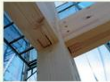
内部に隠れる金物 金物が木材の内部に隠れ木 造の美しさを損ないません。
